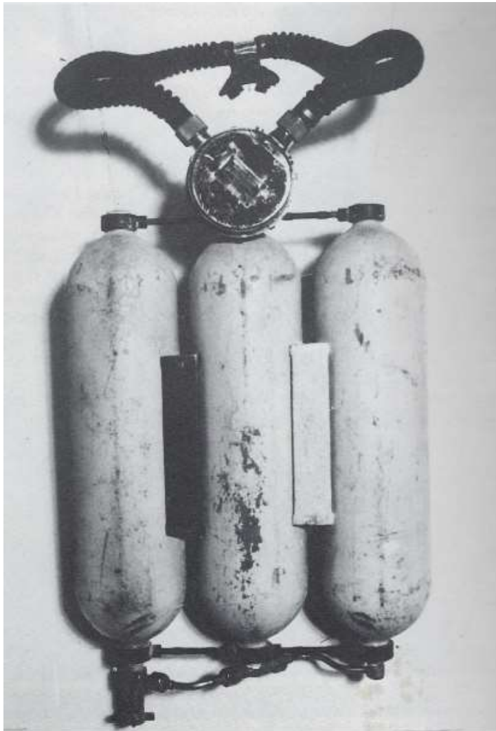
par Jean-Yves Cousteau et Emile Gagnan Premier appareil-plongeur autonome réalisé en 1943
